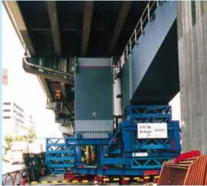
リフトアップ前状況
